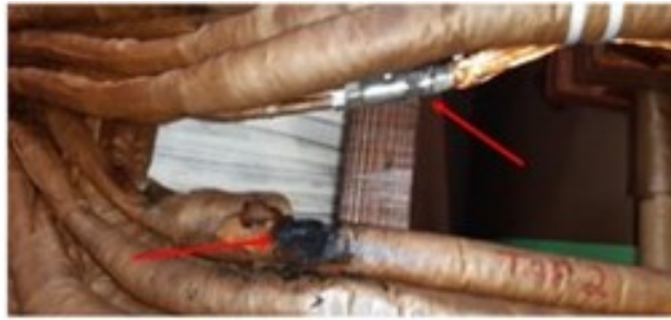
Figura 11: Detalhe no comparativo de uma luva de compressão em bom estado versus deteriorada.
