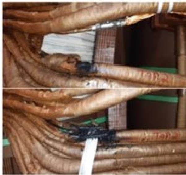
Figura 09: Detalhe da luva de compressão carbonizada.
