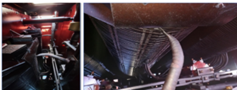
Figura 17: Registros da inspeção internas realizada sem evidências de avaria.
