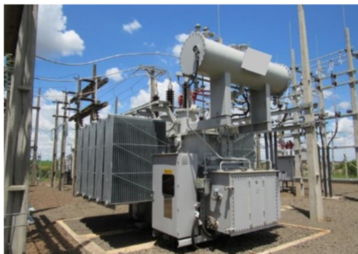
Figura 03: Transformador de força TR-03-13.
